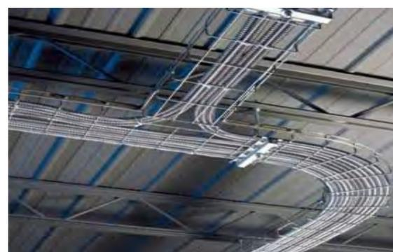
圖 12-15 弱電系統共用纜線架
