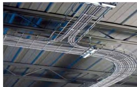
圖 11 弱電系統共用纜線架
